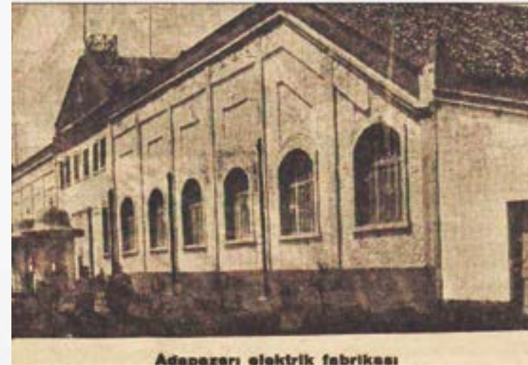
Adapazarı elektrik fabrikası
