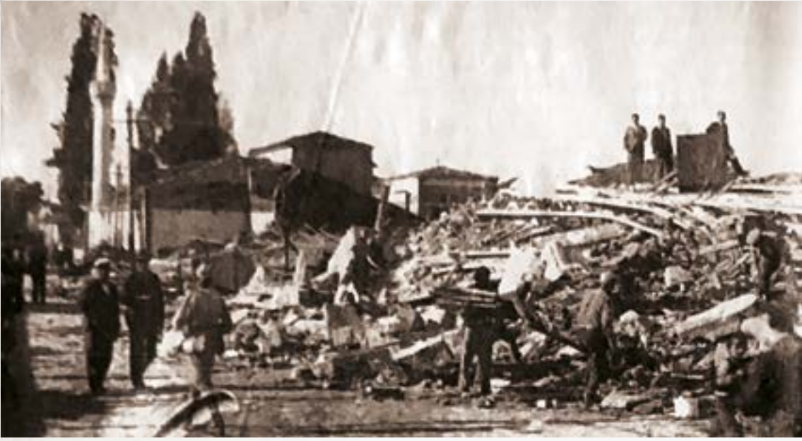
1943 Adapazarı depreminde enkaz olan Banka binası
